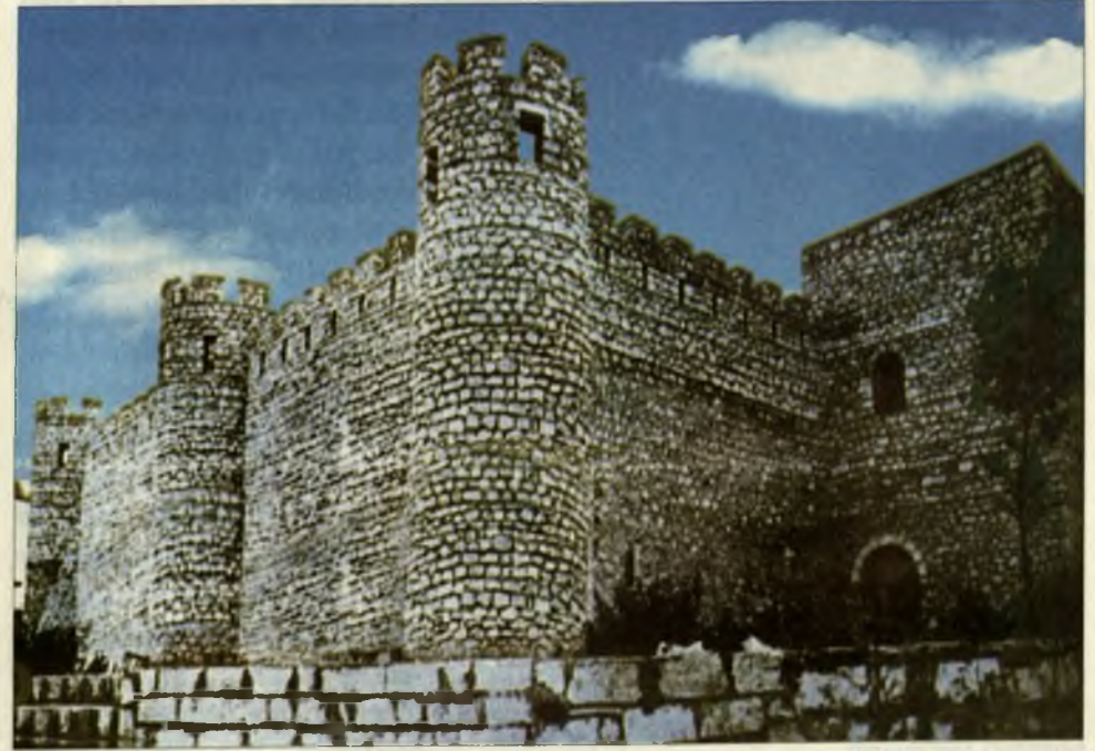
Şuşa – Pənahabad şəhərində Pənahəli xanın qəsri
