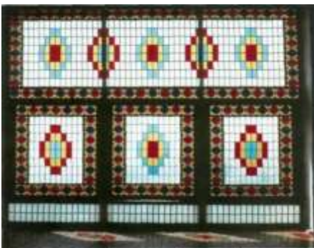
Zöhrabbəyovların malikanəsi. Ümumi görünüş və pəncərə şəbəkəsi. Şuşa şəhəri. The Zokhrabbayovs estate. General view and window. Shusha city. Усадьба Зохраббековых. Общий вид и витражное окно. Город Шуша.
