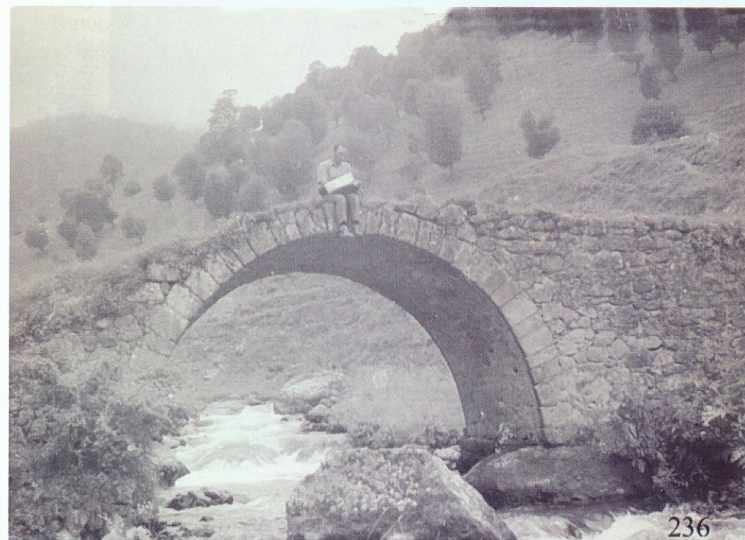
Kəlbəcər ərazisində Xaçın çayı üzərində körpü.
