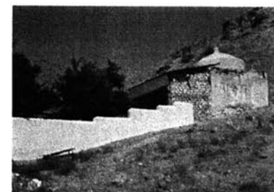
Şəkil 59. Pir-i Süleyman xanəqahı
