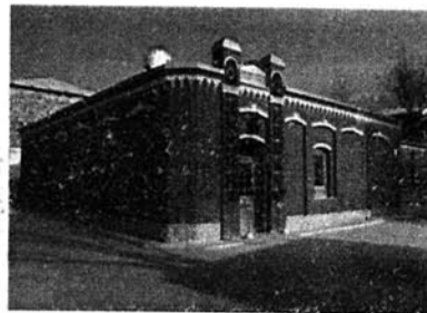
Şəkil 90. Ordubad şəhər hamamı
