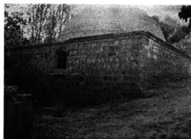
Şəkil 56. Əmirxan türbəsi
