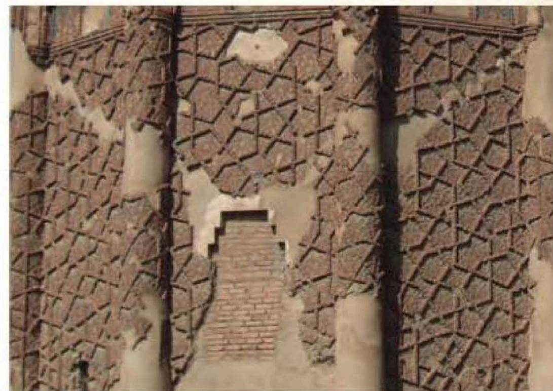
177. Göy Günübd türbəsi, üzlük bəzəyindən fraqment.
