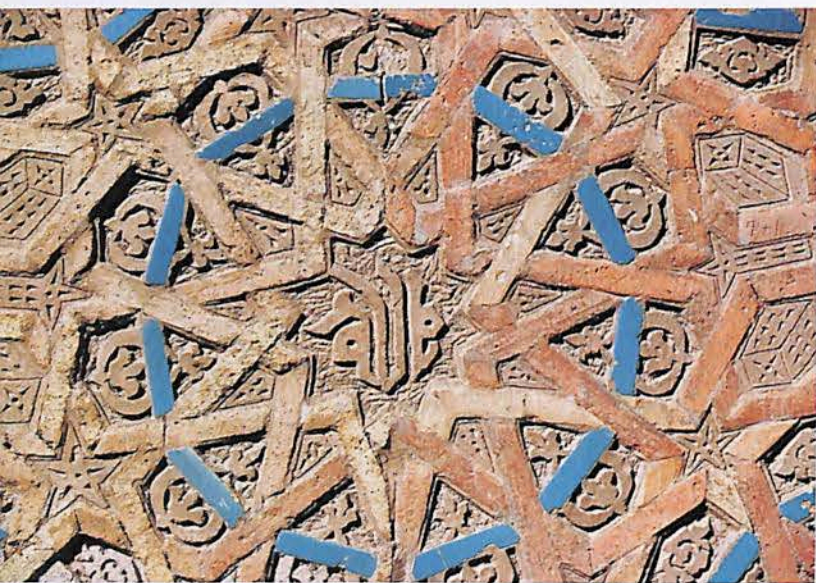
Türbənin fasadlarında mürəkkəb naxış bəzəyinin asan qavranılmasını təmin etmək üçün firuzəyi şirələnmiş xüsusi kərpiclərdən istifadə edilmişdir.
