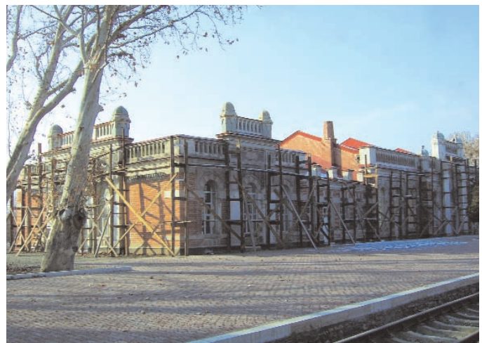
Culfa Dəmiryol vağzalının bərpa vəziyyəti. Julfa Railway station under restoration.
