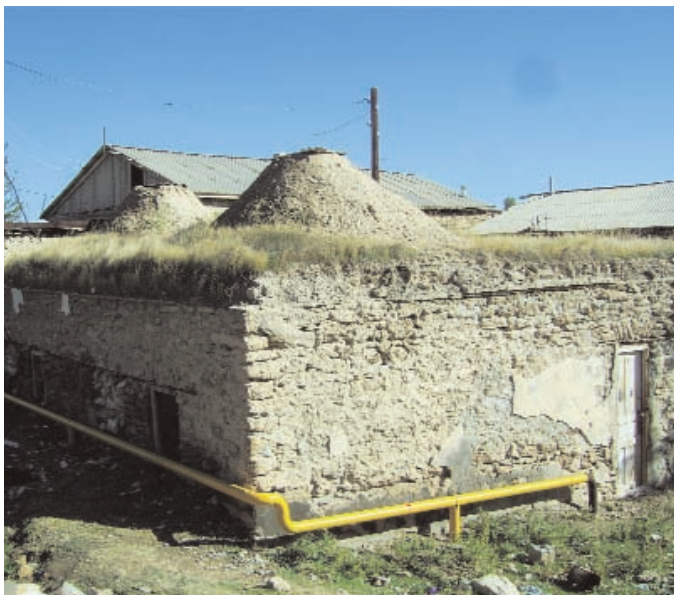
Xok hamamı. Şərur r. Khok bath-house. Sharur r.
