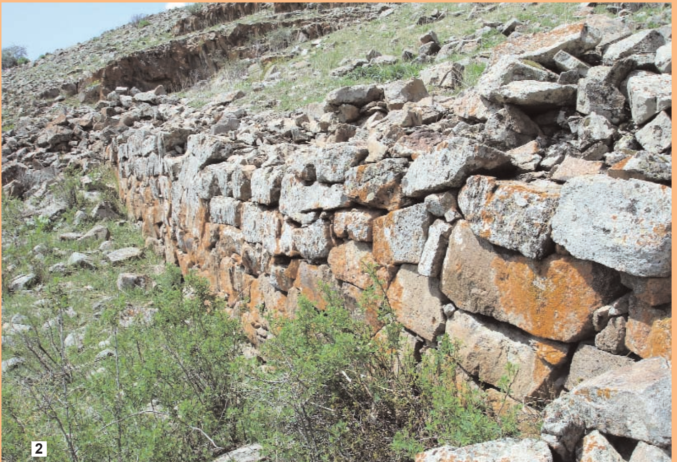
1. Qazançı qalası. Culfa r. 2. Qazançı qalasının divar qalıqları. 1. Gazanchi fortress. Julfa r. 2. Wall remnants of Gazanchi fortress.
