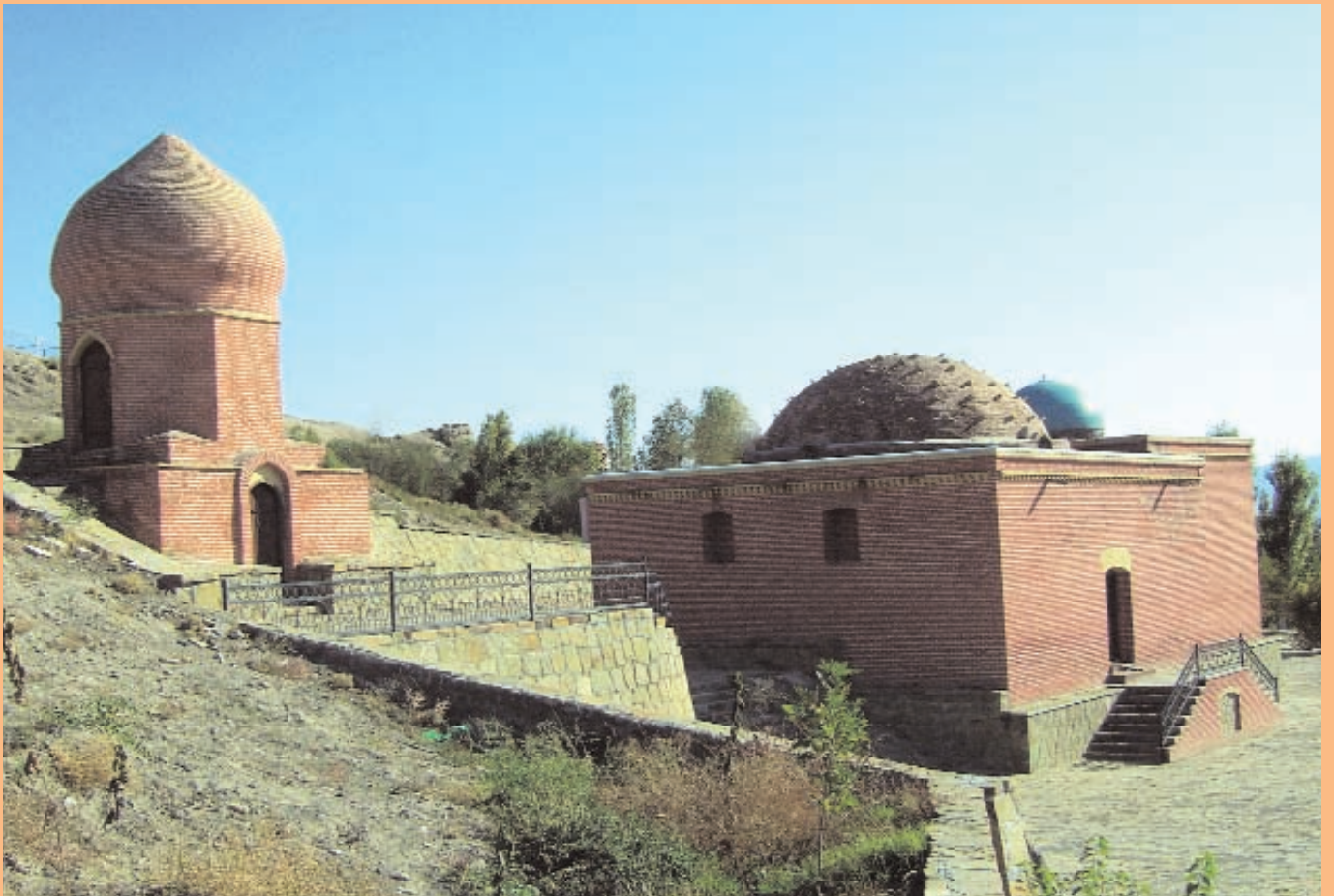
İmamzadə kompleksi. Imamzadeh complex.
