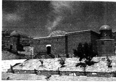
Şəkil 61. Naxçıvan şəhər İmamzadə kompleksi
